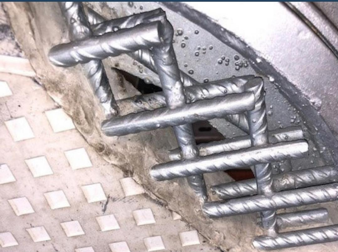
L'utilisation d'armature en acier galvanisé dans les produits et structures en béton présente de nombreux avantages. Dans les environnements agressifs, la nécessité d'augmenter l'enrobage du béton peut être évitée. Dans des conceptions en béton plus léger et plus mince, l'armature en acier galvanisé protège contre la carbonatation lorsque l'enrobage du béton a été réduit.
