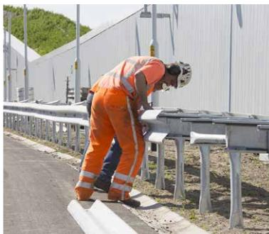
Les glissières de sécurité en acier galvanisé peuvent être démontées pour être réutilisées ou regalvanisées, ce qui permet d'économiser jusqu'à 70 % des émissions de CO<sub>2</sub>.
