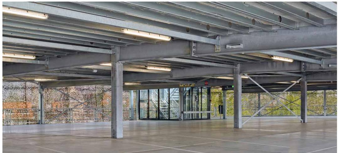
panneaux de façade galvanisés dans une structure de 36,4 mètres de large et 80,4 mètres de long. La galvanisation facilite également l'utilisation de profils plus minces qui permettent à la lumière naturelle de pénétrer davantage dans le parking.
